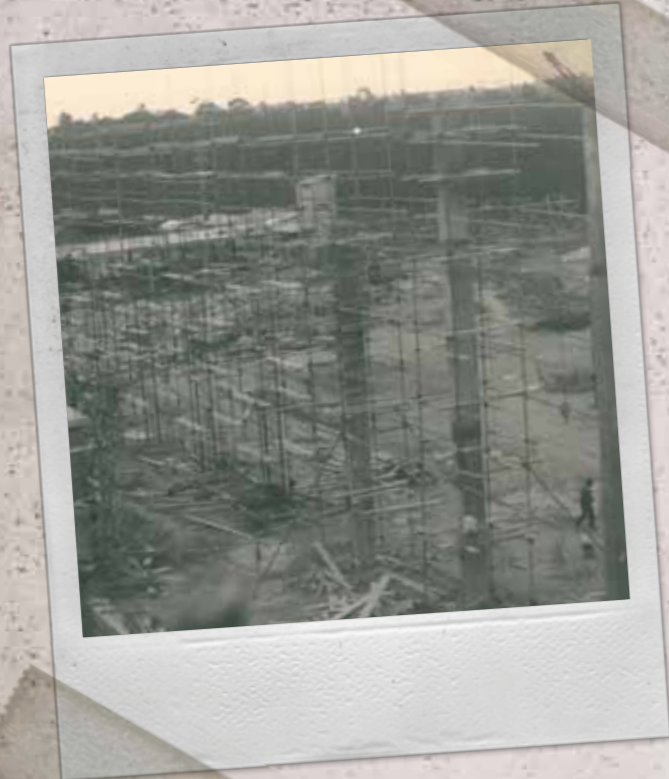
Construção dos primeiros pilares da Antiga Central de Compostagem Construction of the first pillars of the former Composting Plant.
