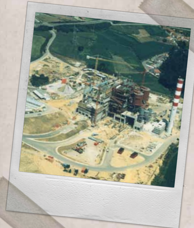
Construção da Central de Valorização Energética Energy Recovery Plant construction.
