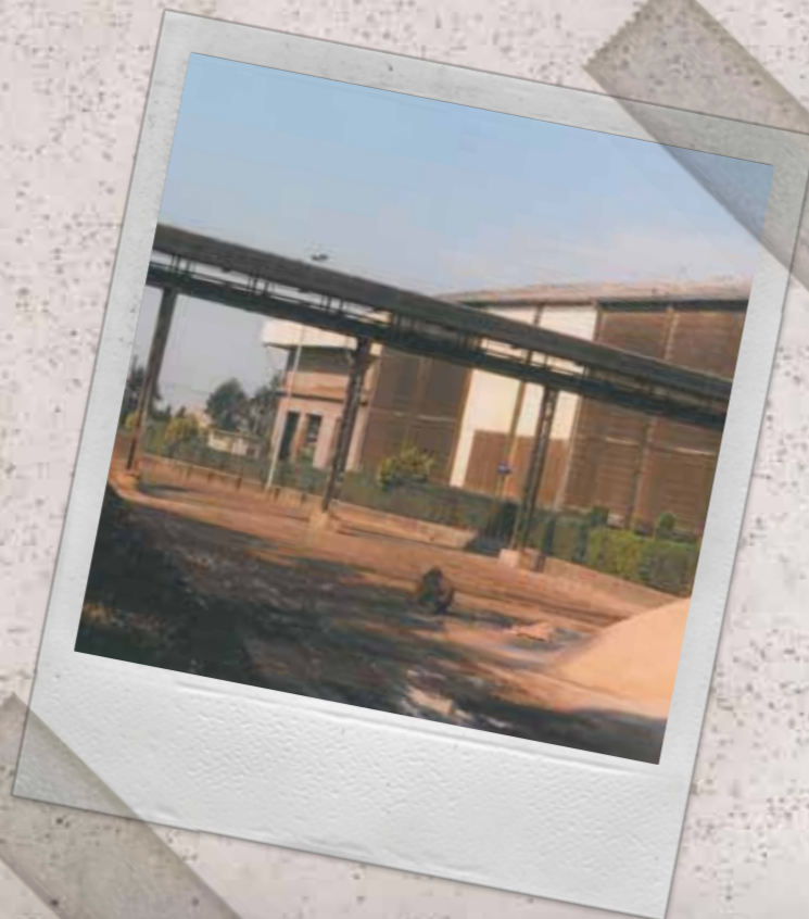
2.ª Linha da Antiga Central de Compostagem Second line of the former Composting Plant.
