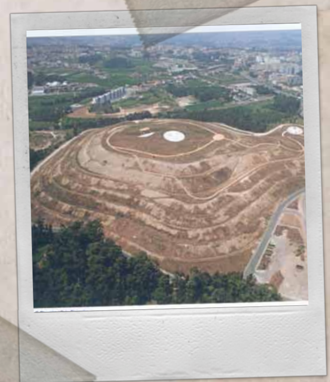
Selagem do Aterro de Ermesinde Sealing of the Landfill of Ermesinde
